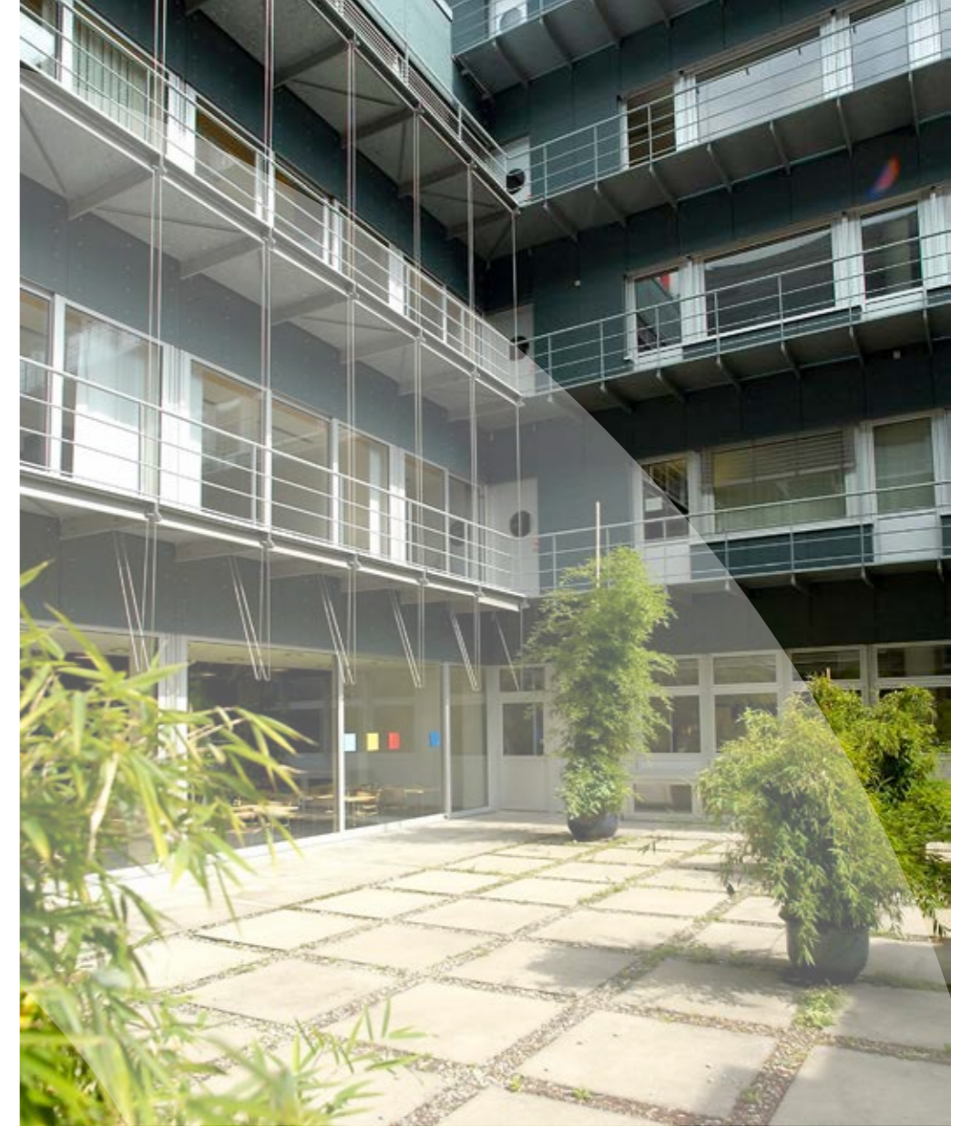
Technopark Zürich, Bereich Büro/Verwaltung >
